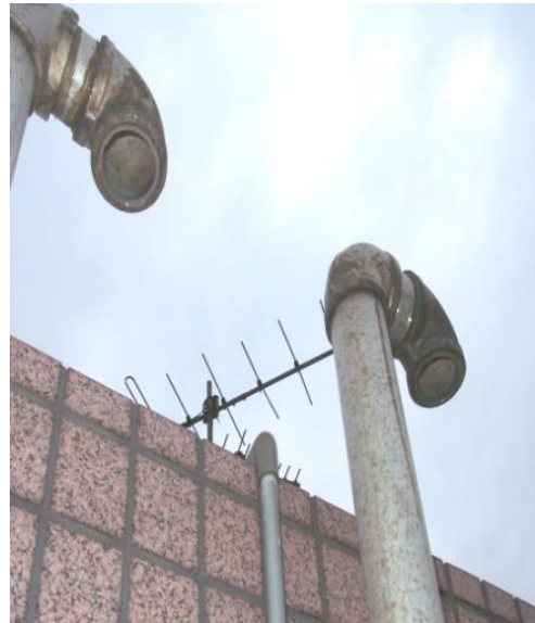
通氣管加裝防蟲網
